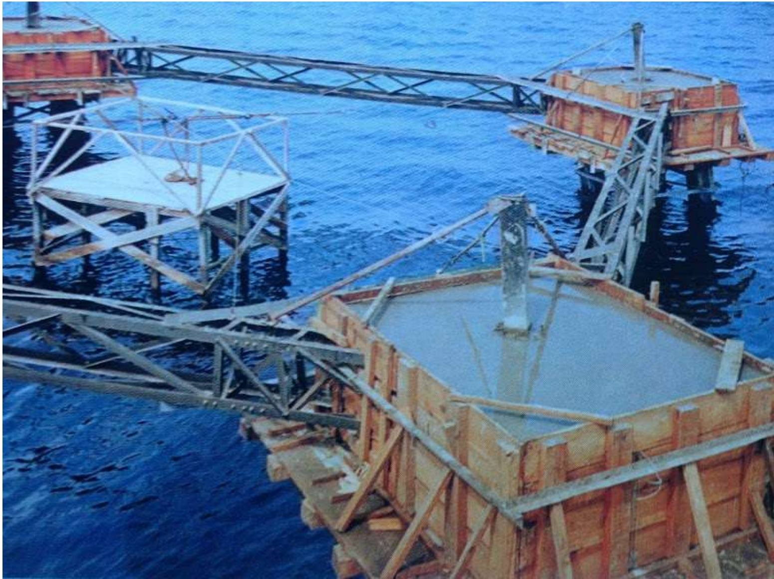
LAGOS CENTRALE DI Iwopin fondazione in acqua della linea elettrica di alimentazione della città
