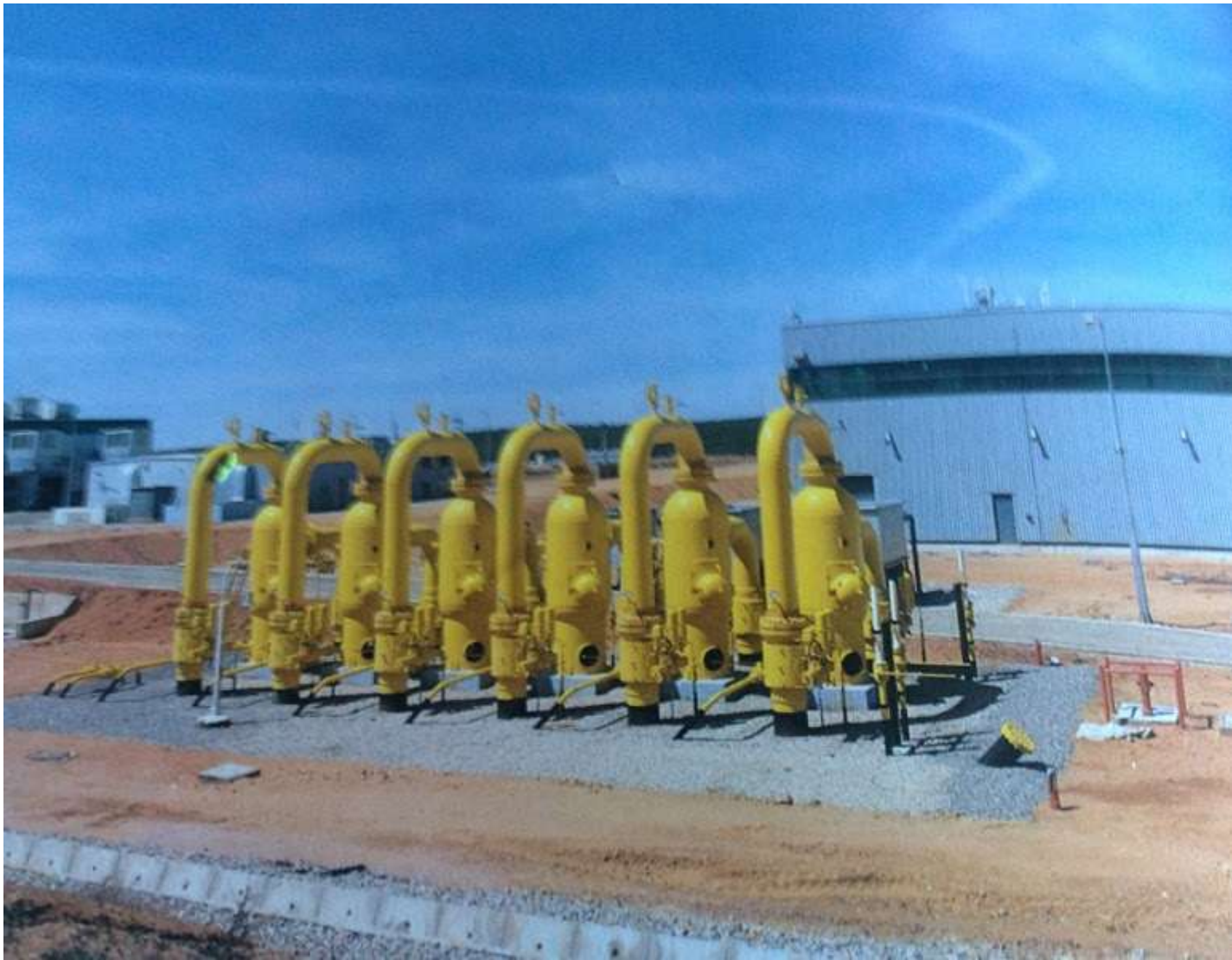
STAZIONE DI POMPAGGIO GASDOTTO, HASSI'L'MEL-ARZEW
