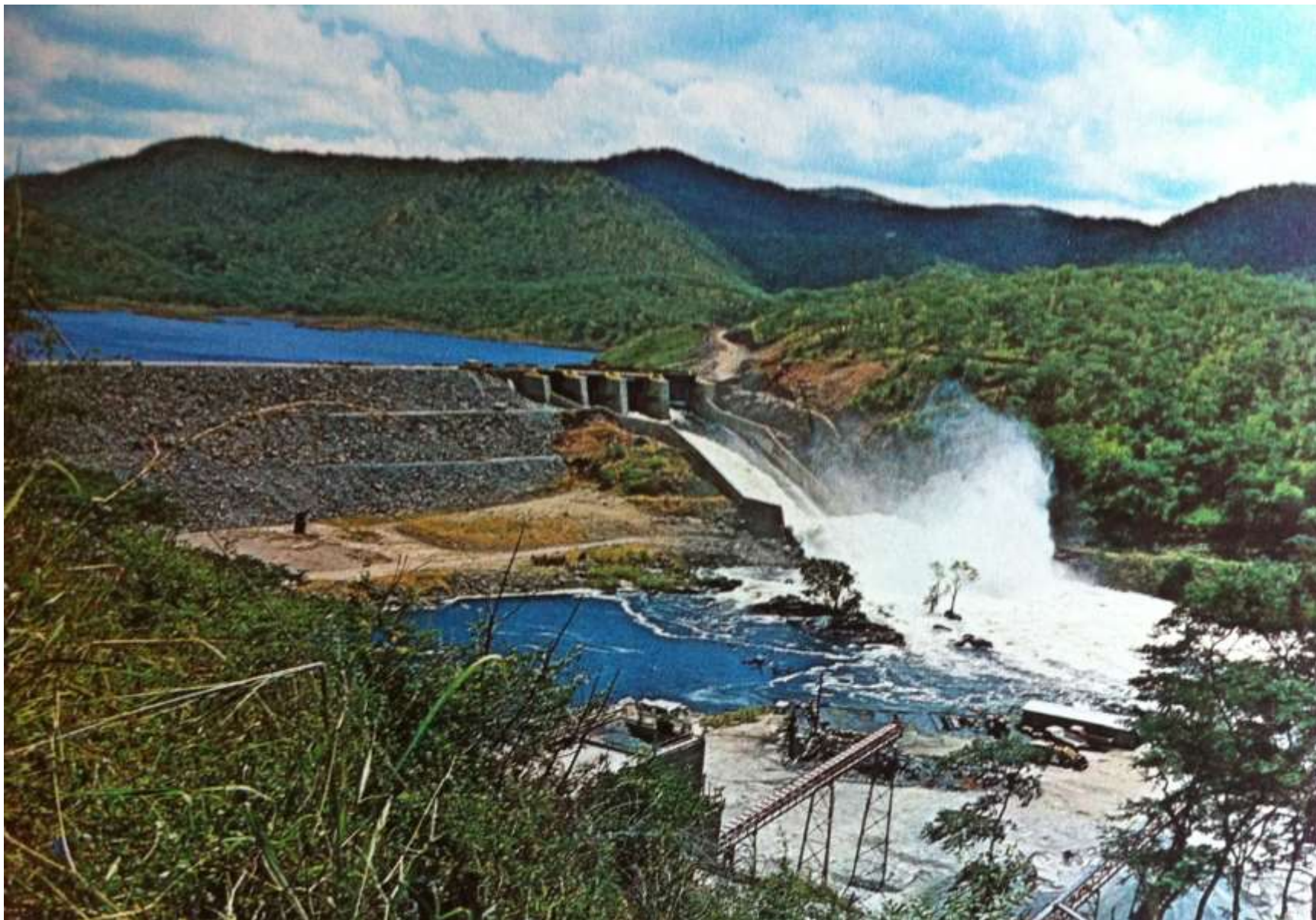
CENTRALE IDROELETTICA DI KAFUE
